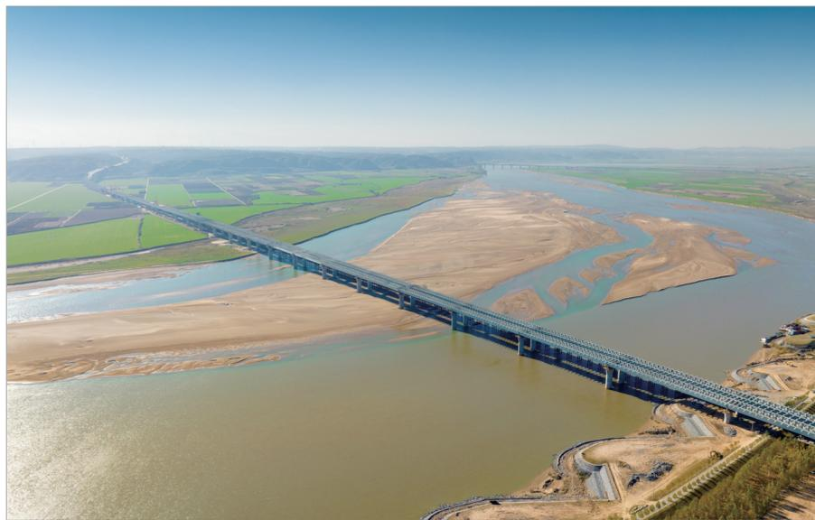
11月29日,由公司承建的河南沁伊高速公路黄河特大桥主桥顺利合龙,大桥建设转入桥面系施工阶段。
